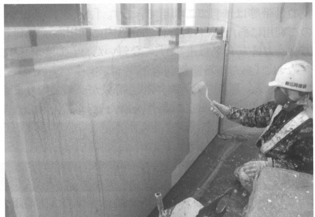
廊下 塗装下塗り
